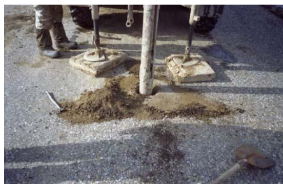
Рисунок 3 - Машина УГБ 50М в процессе бурения пневмостаканом
