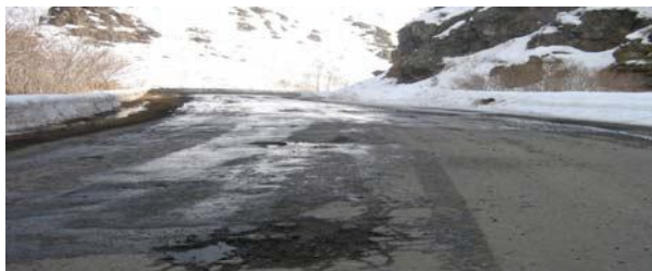
Рисунок 5 - Опытный участок на автомобильной дороге «Усть-Каменогорск-Самарское», 17 км. В весенний период, 29 апреля 2003 года
