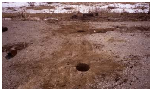
Рисунок 10 - Пробуренная дорожная конструкция посередине проезжей части, посередине полосы движения
