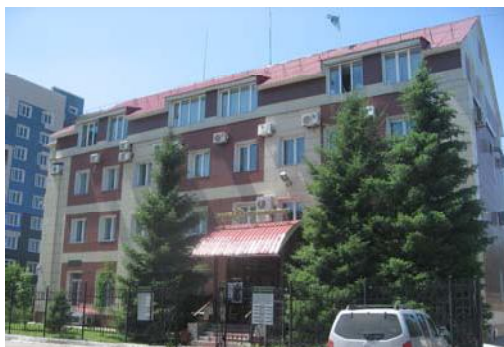
Рисунок 3 – Мансардная надстройка над зданием банка Центр Кредит по ул. К. Либкнехта, 17
