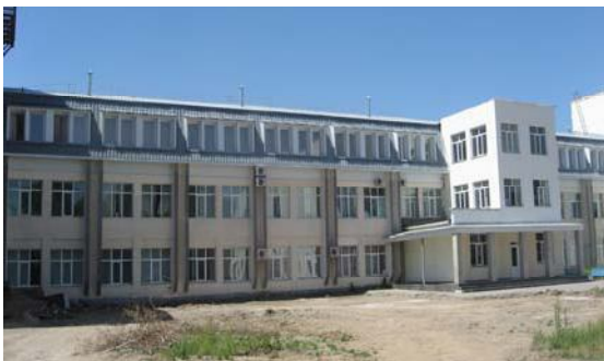
Рисунок 1 – Мансардная надстройка над переходной галереей ВКГТУ им. Д. Серикбаева
