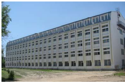
Рисунок 2 – Мансардная надстройка над учебным корпусом ВКГТУ им. Д. Серикбаева
