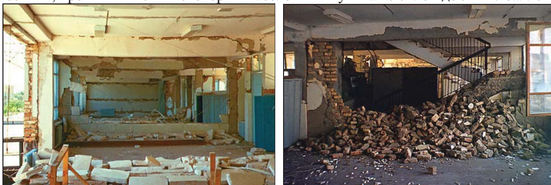
Рисунок 1 – Состояние некоторых несущих и самонесущих элементов зданий при Газлийском (а) и Спитакском (б) землетрясениях
