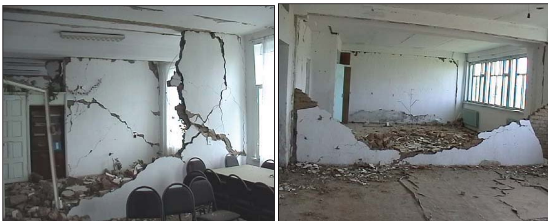
Рисунок 2 - Состояние кирпичных перегородок в каркасных зданиях акимата (а) и трехэтажной школы (б), расположенных на станции Луговая
