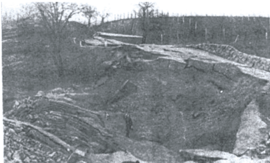
Рисунок 1- Оползень, разрушивший дорогу
