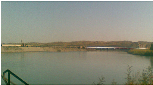
Рис.2. Возведение временной насыпи с целью погружения через нее свай
