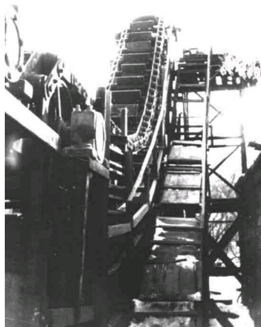
Рисунок 4 - Крутонаклонный конвейерный подъемник ПН-80 на полигоне
