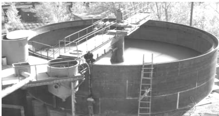
Рис. 1. Стуститель на площадке чанового выщелачивания золота (АО "ГМК КазахАлтын")
